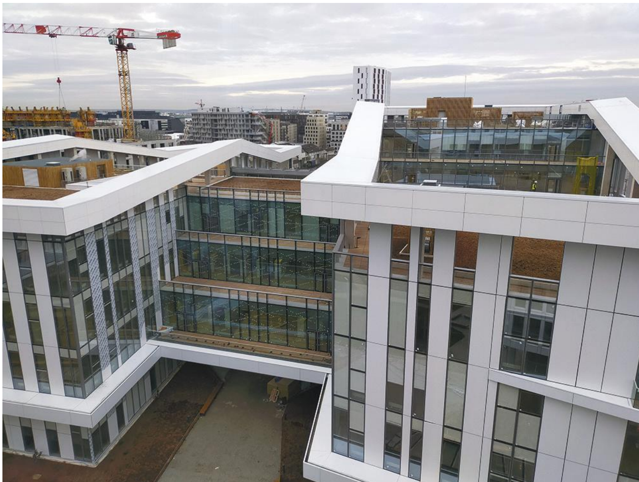
Le chantier du bâtiment du GED. Février 2021 © Alicia León y Barella
